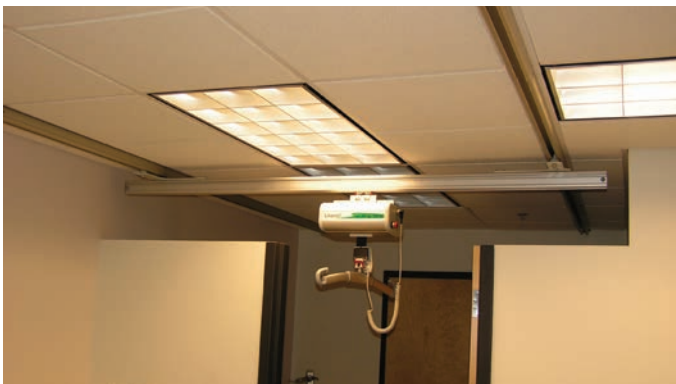
Sænkede badeværelsesvægge for at gøre plads til, at sekundær skinne kan passere
